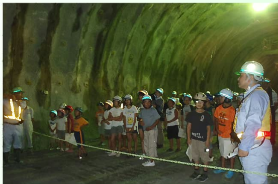
掘削箇所での工事説明
