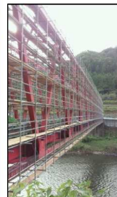
足場の組立状況
