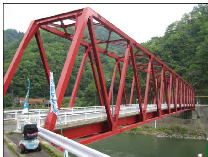
補修後の丹渡橋（左岸上流側から）
