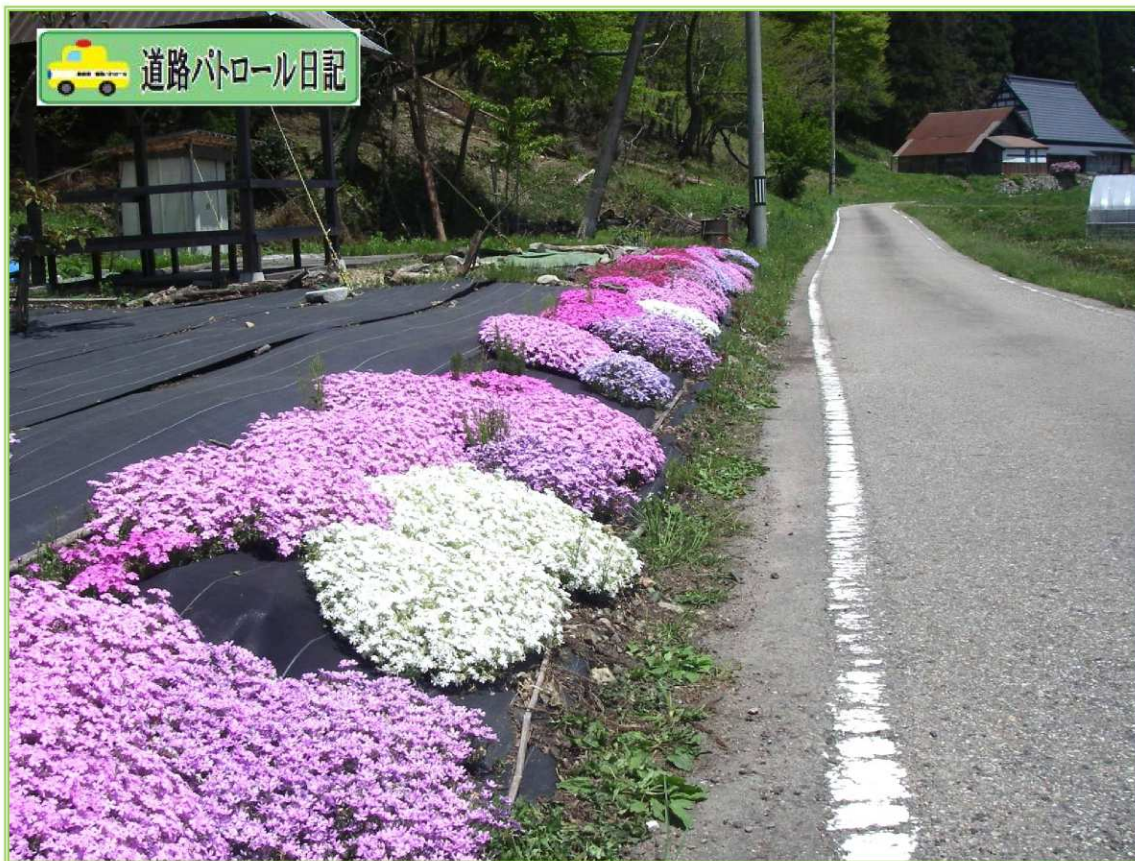
県道波佐匹見線(益田市匹見町道川)
