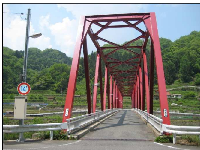
補修後の丹渡橋（右岸側から）
