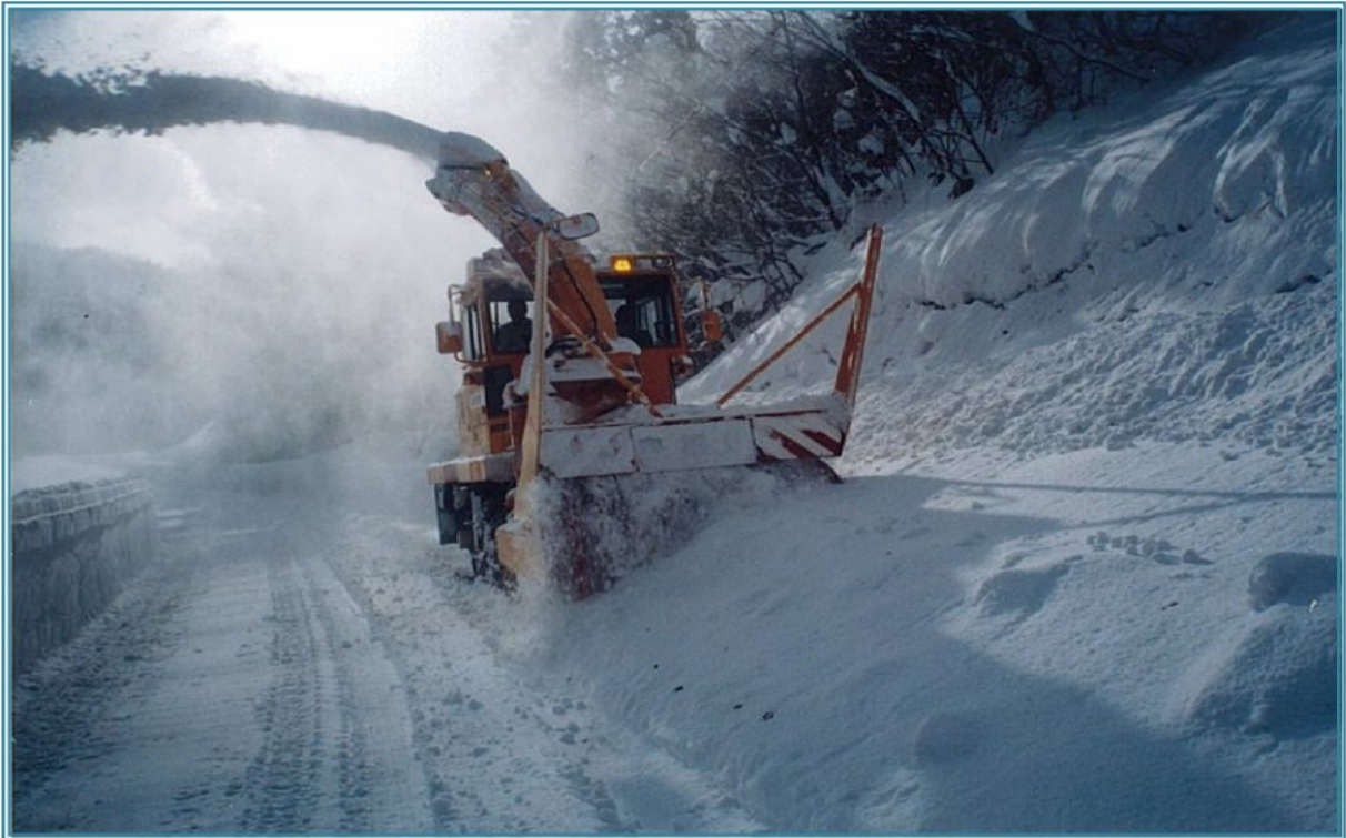
除雪の様子(国道186号:浜田市金城町長田)
