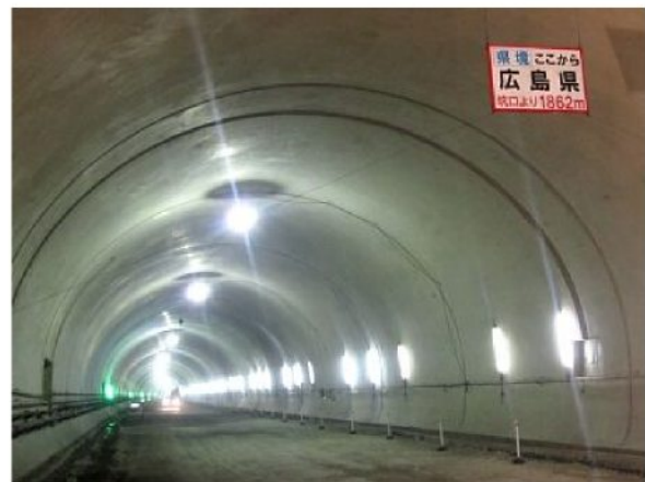
島根県側坑口部から1,862m進んだ先に、広島県境を示す表示がありました。この先は広島県です。
