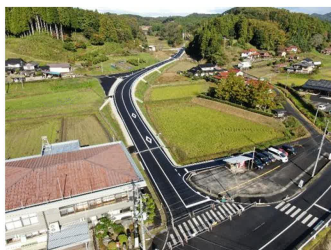
農道終点側の完成状況（大東町仁和寺地内）
