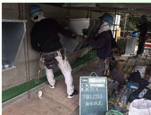
水平力分担装置 設置状況
