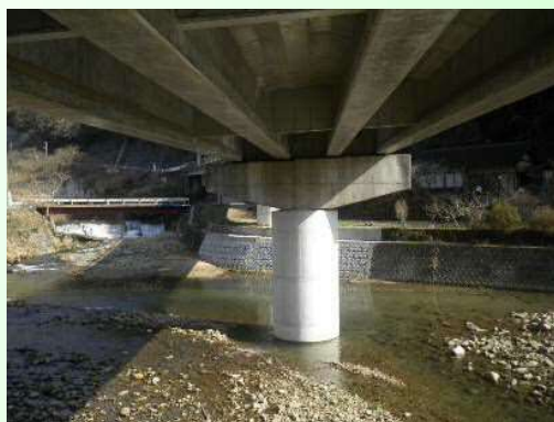
水平分担装置（施工前）
