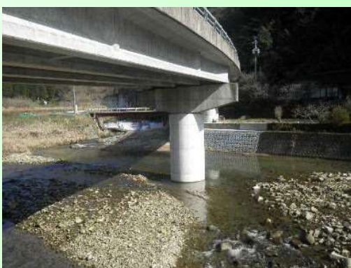
水平分担装置（施工前）
