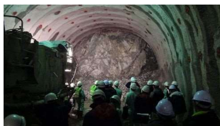
掘削面の状況（2月末時点）
