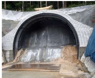
トンネル多田側坑口（掘削前）
