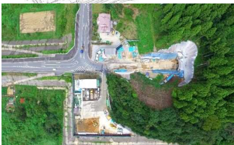
多田側坑口付近（ドローンで空撮）
