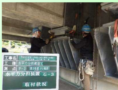
水平力分担装置 設置状況
