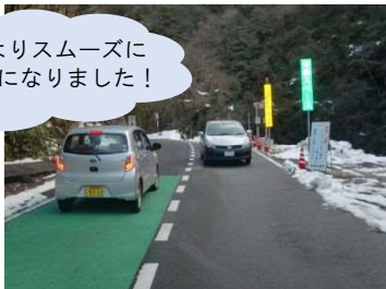
写真③ 設置後状況
