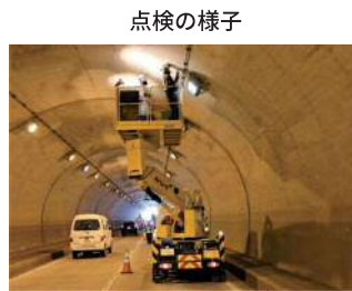
トンネル点検
