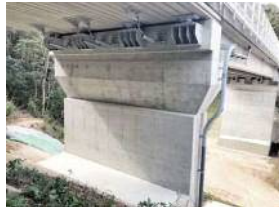
(主)松江鹿島美保関線 小女良橋(松江市)
