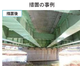
橋梁 鋼桁の再塗装
