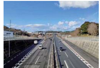
既に4車線化されている国道9号松江道路
