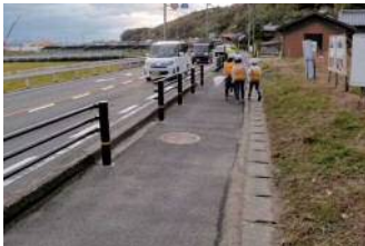
国道431号(出雲市)
