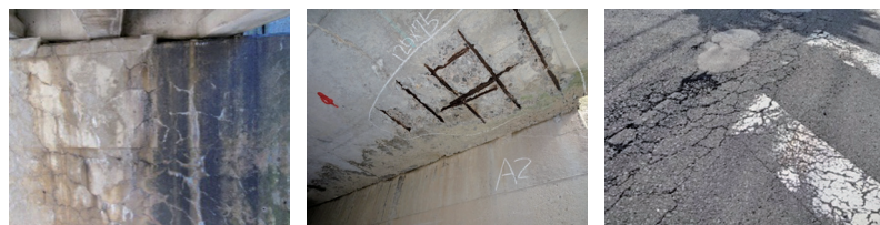
橋梁 橋脚のひび割れ
