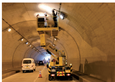
トンネル点検
