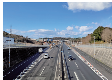
既に4車線化されている国道9号松江道路
