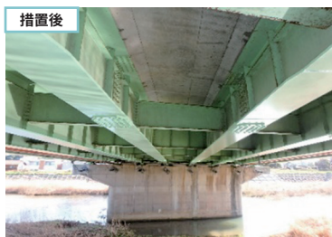
橋梁 鋼桁の再塗装
