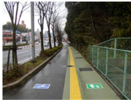
写真 路面標示により歩行者と自転車の通行空間を分離した事例（松江市） （出典：島根県道路維持課）
