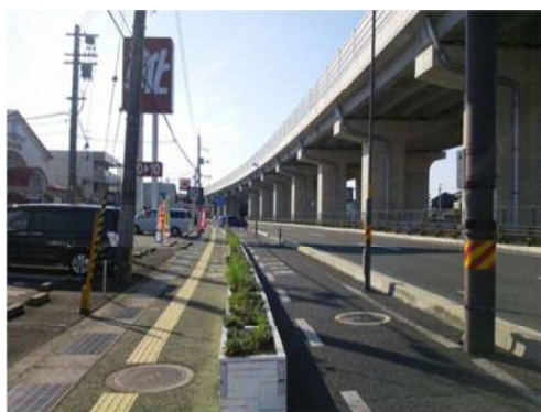
写真 構造的に分離された自転車通行空間（自転車道）の整備事例（松江市） （出典：島根県道路建設課）
