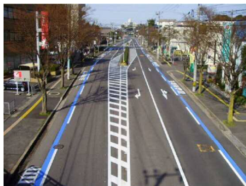
写真 自転車ネットワーク計画に基づき自転車専用通行帯が設置された事例（松江市） （出典：松江市「松江市自転車ネットワーク計画」）
