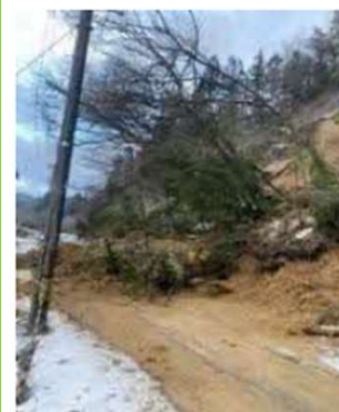
土砂崩落復旧前
