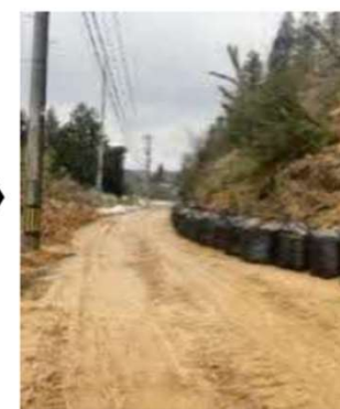
道路啓開後(1車線確保)
