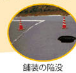
舗装の陥没
