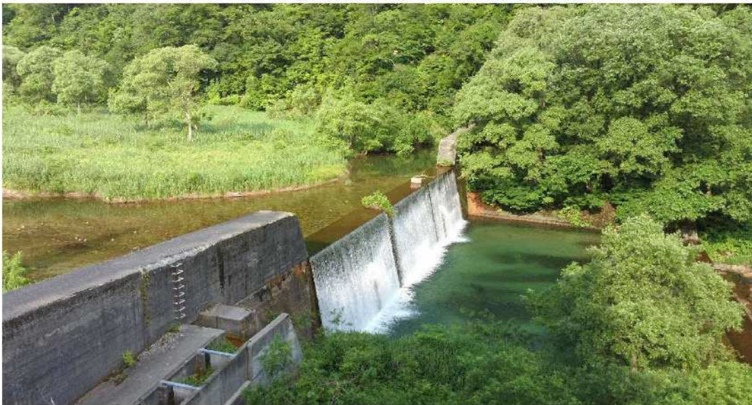
【堰堤下流面の俯瞰撮影例（堰堤下流の俯瞰撮影）】
