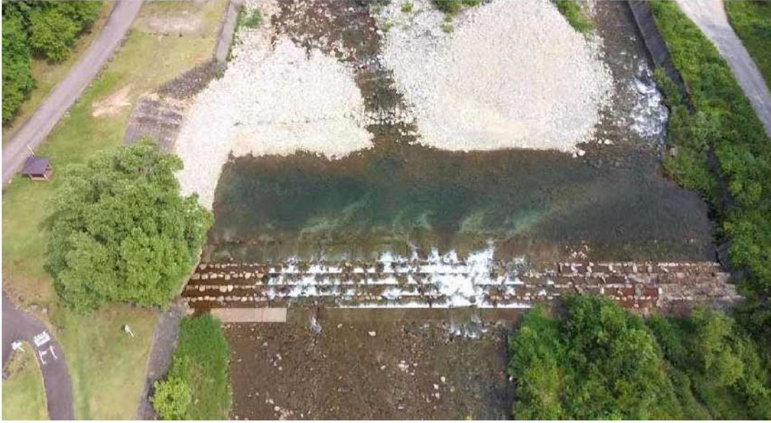
【UAV 点検における溪流保全工撮影(斜め撮影例)】
