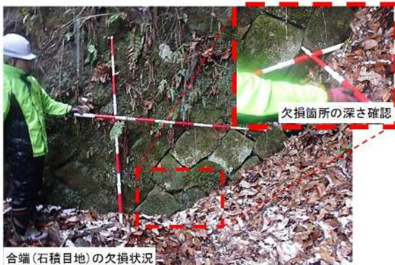
合端(石積目地)の欠損状況
