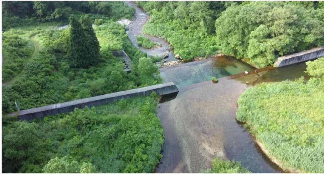
【砂防堰堤の俯瞰撮影例（堰堤下流の俯瞰撮影）】
