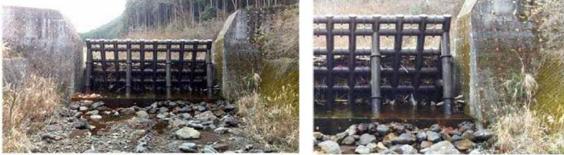
【正立面画像による透過型堰堤部材変状確認例（水平正画像撮影）】
