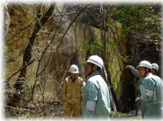
砂防えん堤点検の様子
