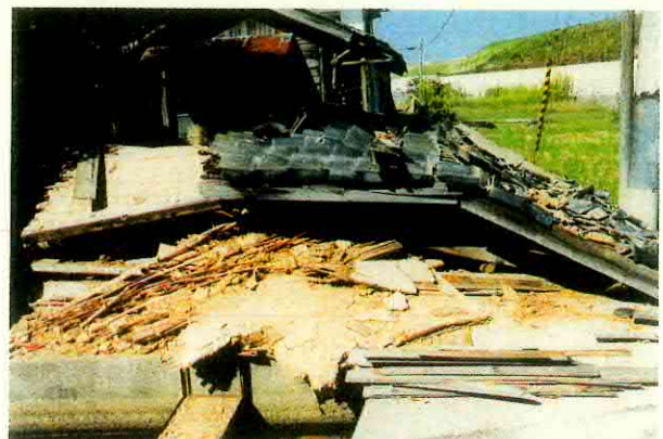
全壊した家屋（安来市）
