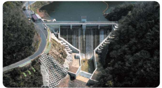
笹倉ダム [平成19年3月完成]
