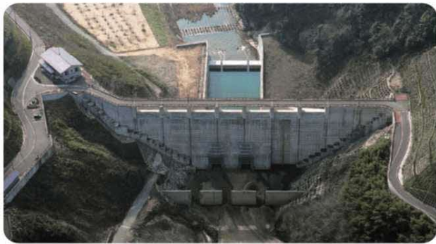
益田川ダム [平成18年3月完成]
