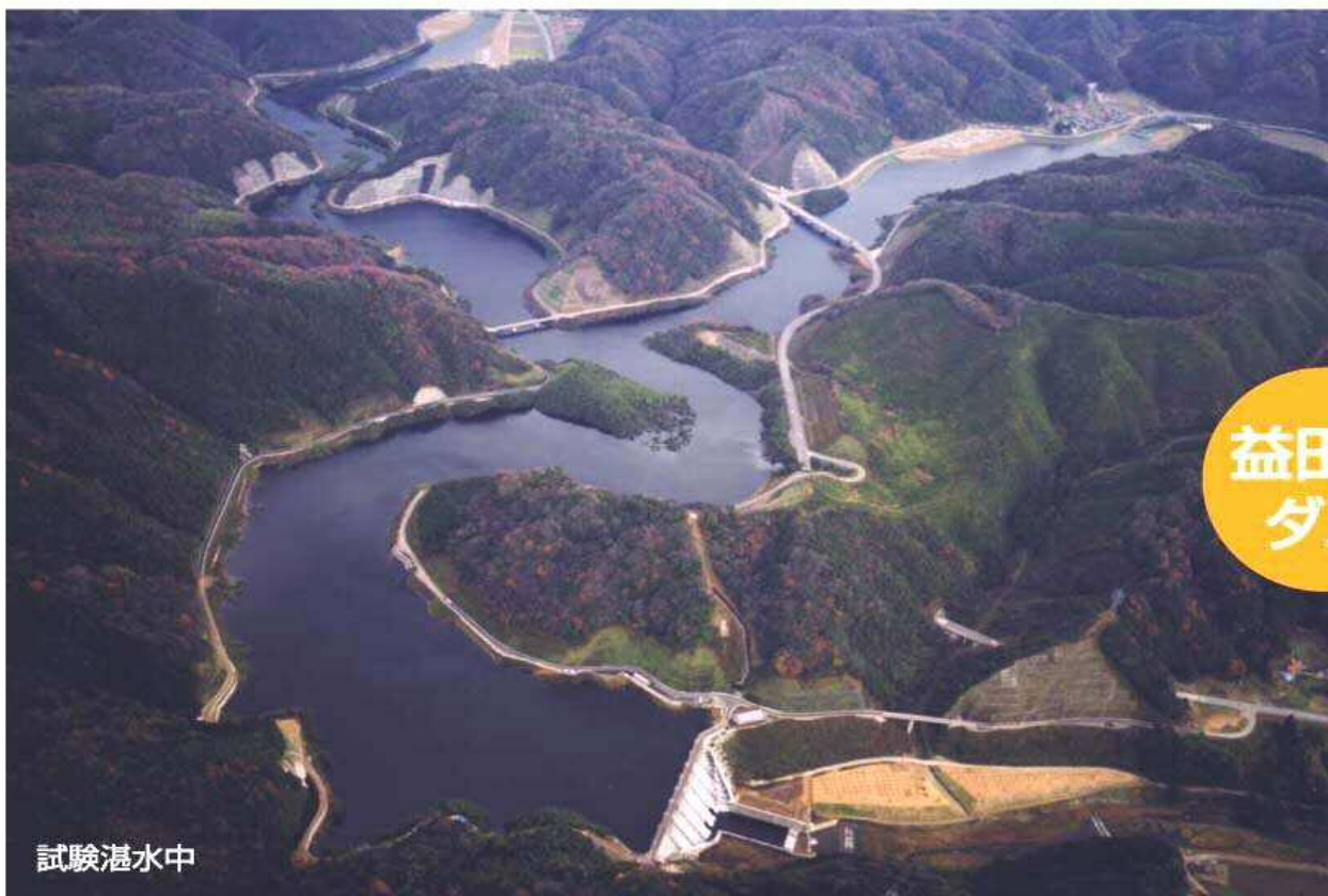
益田川ダム完成写真 (試験湛水中)
