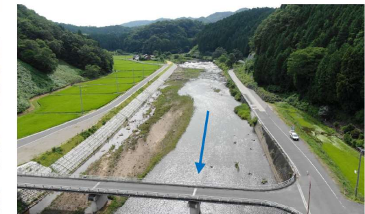
終点付近から中間付近を望む
