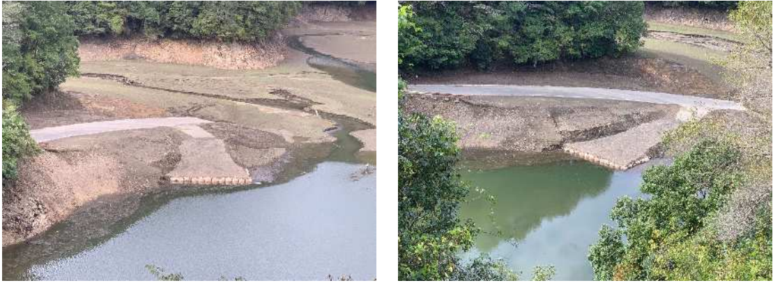
図 3 安養寺管理道湖面周辺状況写真（撮影時の貯水位 EL=91.45m）
