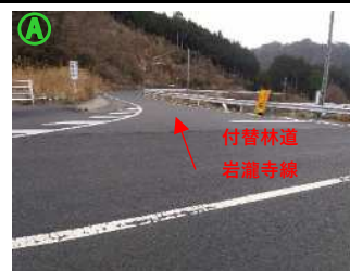
付替林道起点部
