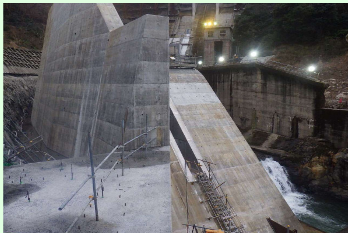
右岸副ダム施工状況
