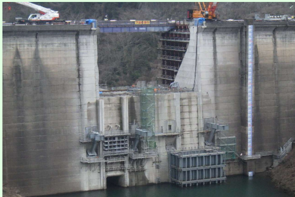
上流仮締切施工状況
