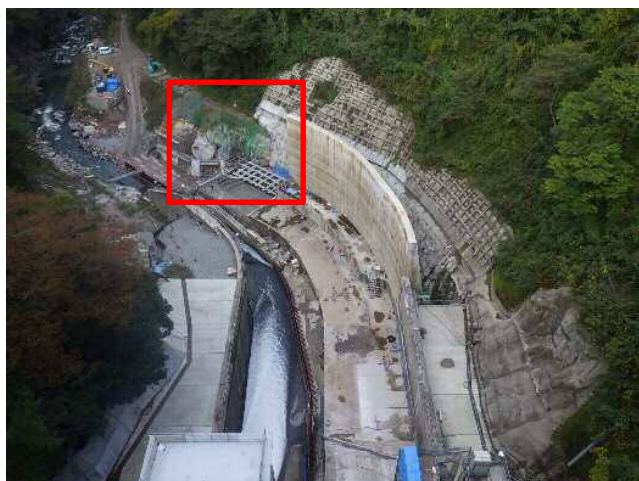
減勢工施工位置
