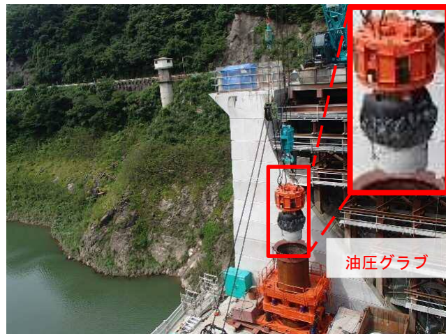
油圧グラブでコンクリート塊をキャッチ！
