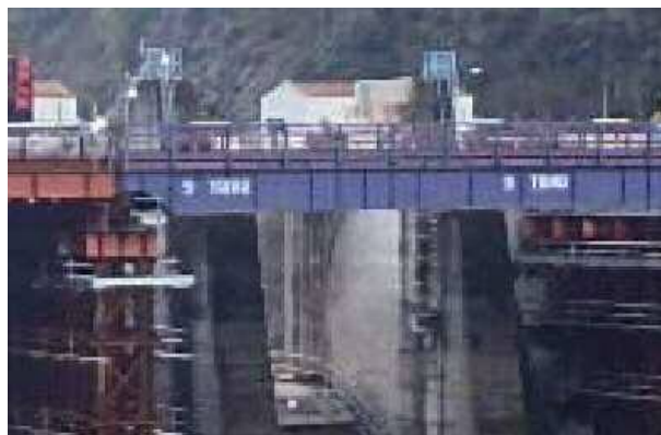
クレストゲート撤去後
