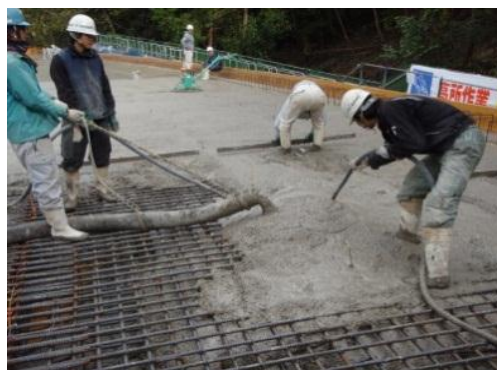
コンクリート打設中
