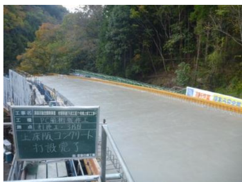
コンクリート打設完了
