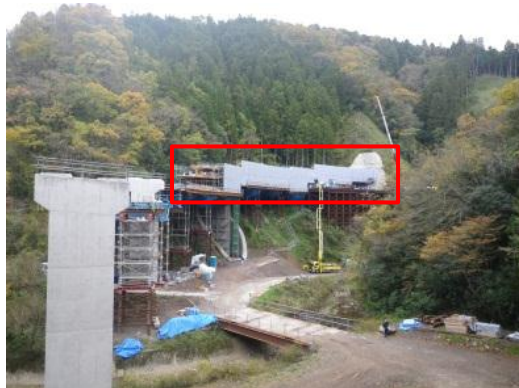
7号橋全景（赤枠の部分を打設）
