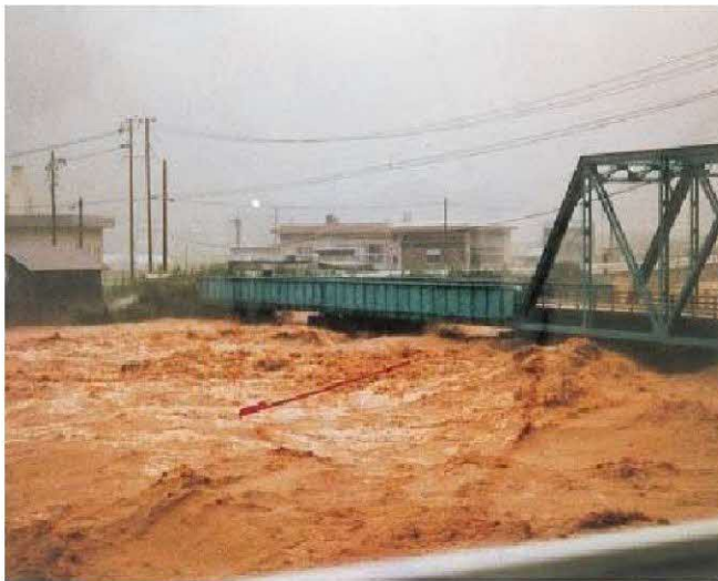
昭和58年災害の時の周布川（松本橋）
