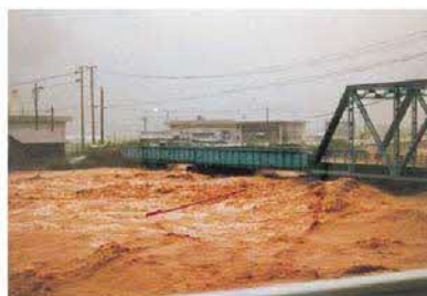
写真 周布川（松本橋付近）
