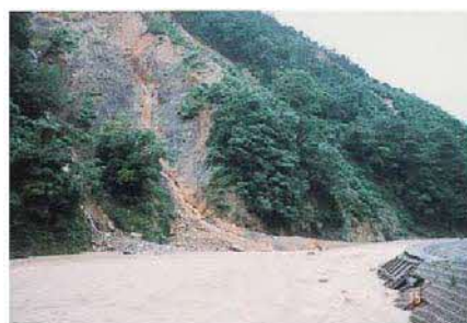
写真 周布川（観音トンネル付近）
