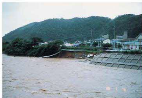
写真 周布川（本郷橋付近）
