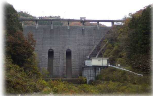
下流側からダムを望む
