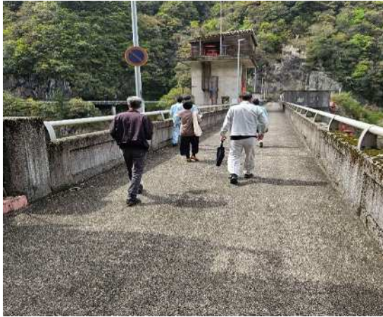
ダム天端(4月17日)
