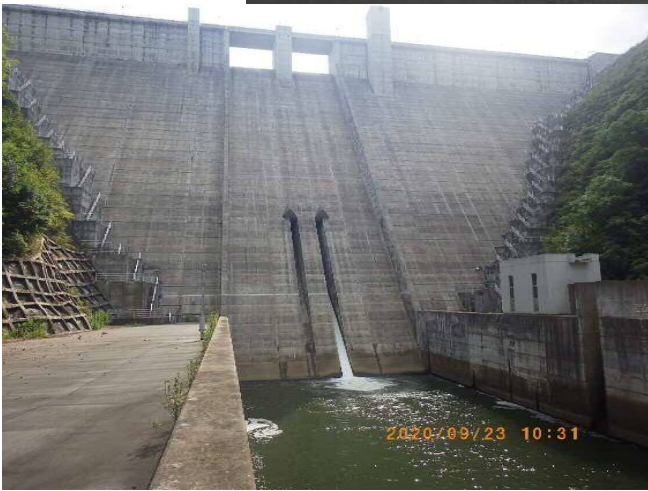
第二浜田ダム
