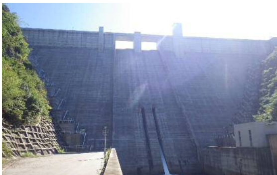
下から見た第二浜田ダム
