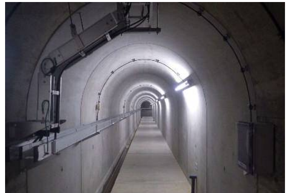
ダムの内部（監査廊）
