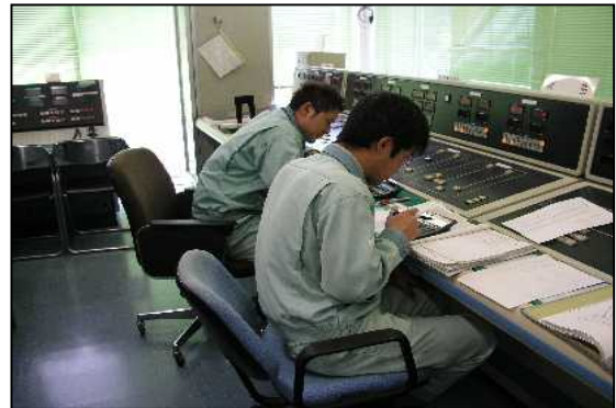
降雨量から流入量、放流量計算状況
