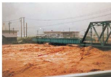
写真 周布川（松本橋付近）
