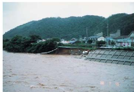
写真 周布川（本郷橋付近）
