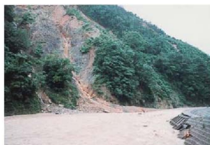
写真 周布川（観音トンネル付近）
