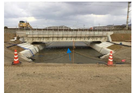
写真③ 完成写真
