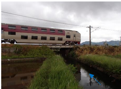
写真① 改築前写真
