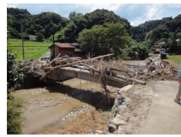
氾濫の原因となった橋梁 (飯石川 雲南市三刀屋町)
