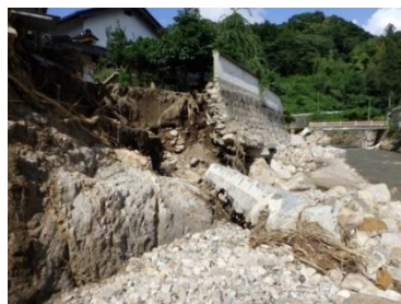
護岸被災状況 (飯石川 雲南市三刀屋町)
