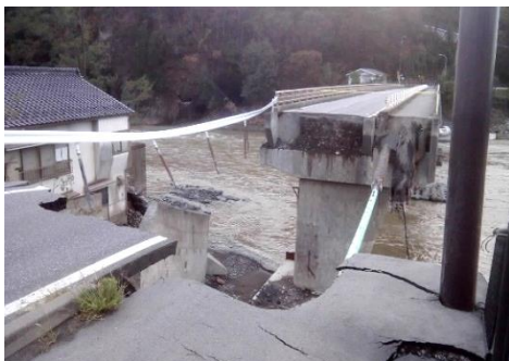
(主) 丸子東部インター線 田中橋 (東御市)
