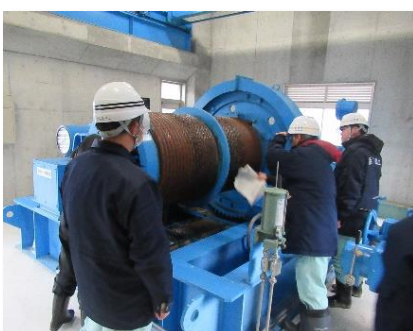
書類検査 (取水ゲート設備)
