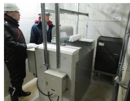
現地確認検査 (ダムたわみ測定装置)
