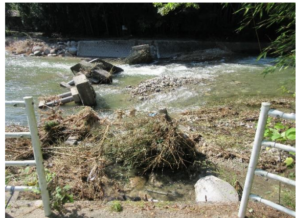
常陸太田市折橋町（十ヶ上橋）
