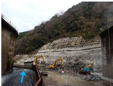
基礎掘削施工状況
