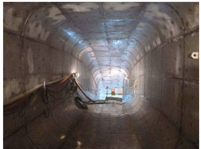
補強工事完了（右側放流管）
