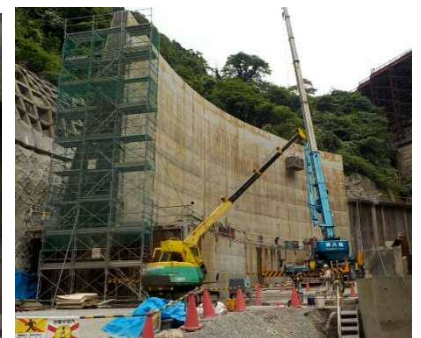
導流壁施工状況
