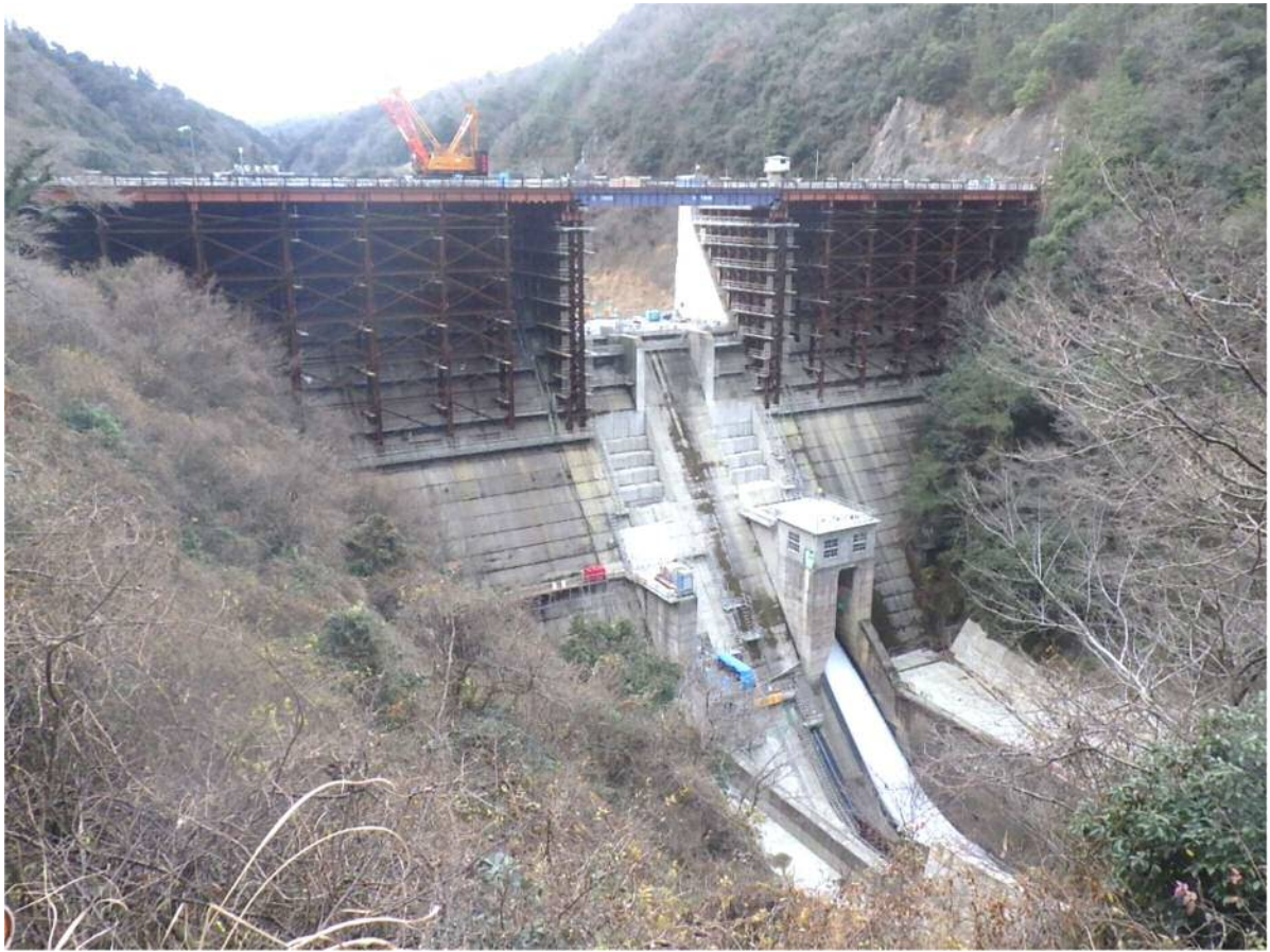
浜田ダム再開発工事の様子（H29.12 撮影）
