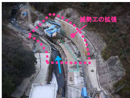
減勢工施工状況（全景）
