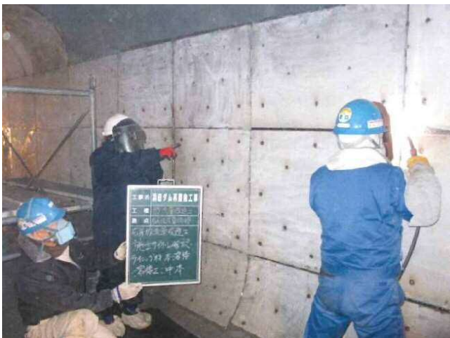
ステンレспанネル設置状況（溶接作業）
