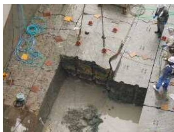
吊り出し状況
