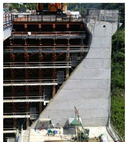
コンクリート切断面
