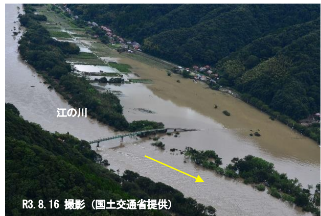
江の川浸水状況(江津市)
