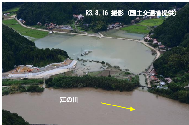
江の川浸水状況(江津市)
