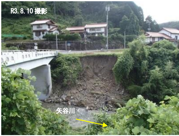
矢谷川被災状況(川本町)
