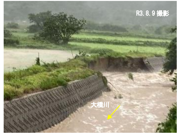
大橋川被災状況(西ノ島町美田)
