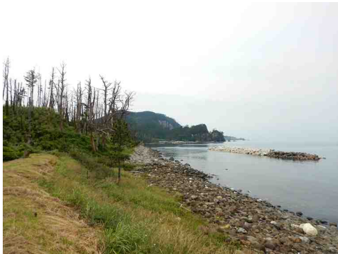
【老朽化対策】西村港海岸（隠岐の島町）
