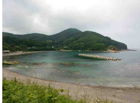
【侵食対策】美田港海岸（西ノ島町）
