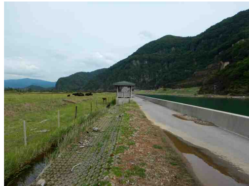
【老朽化対策】五箇海岸重栖地区（隠岐の島町）
