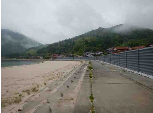
【高潮対策】別府港海岸（西ノ島町）
