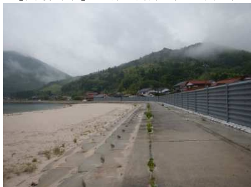
【高潮対策】別府港海岸（西ノ島町）
