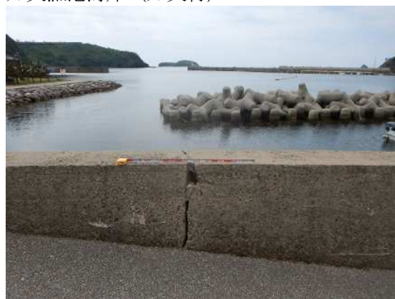
写真-2.1 海岸保全施設の老朽化の事例
