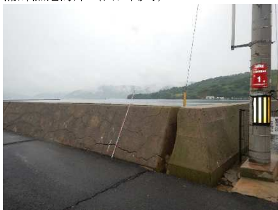
写真-2.1 海岸保全施設の老朽化の事例
