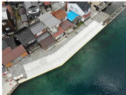
【高潮対策】西郷港海岸（隠岐の島町）
