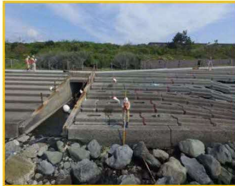
① 先端方塊下部の空洞発生終点(No.3+2.0)
