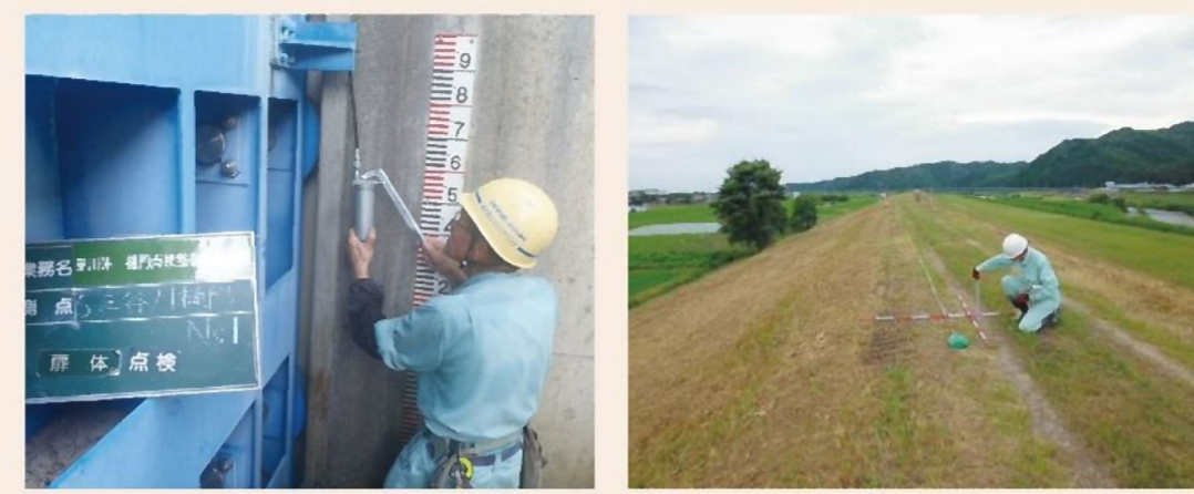
樋門の点検状況 堤防の点検状況
