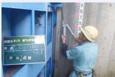
樋門の点検状況
