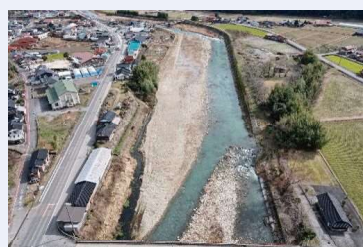
河道掘削・樹木伐採実施状況
