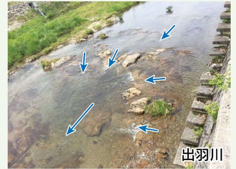
露頭している岩盤を無理に掘削せず、凹凸のある河床にすることで、多様な流れを創出しています。
