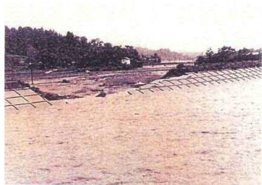
赤川堤防の決壊（雲南市大東町）
