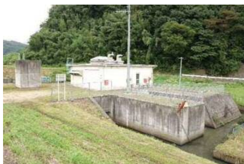
堂の前川排水機場
