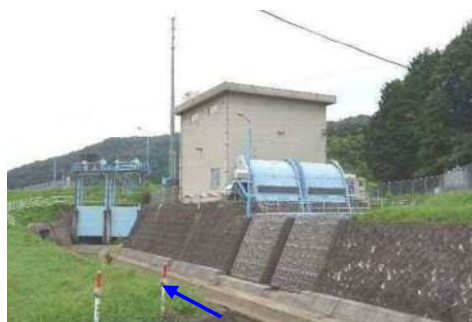
奥田川排水機場
