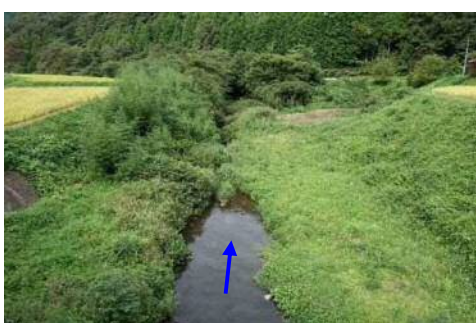
⑫・1 鴨倉大橋下流 (阿井川)
