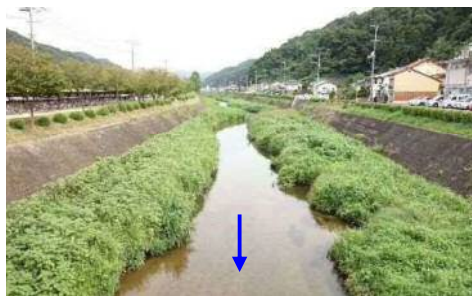
⑧・2 学園橋上流 (久野川)
