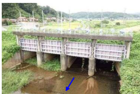
中村川大樋門
