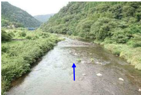
②・1 漆仁橋下流（斐伊川）
