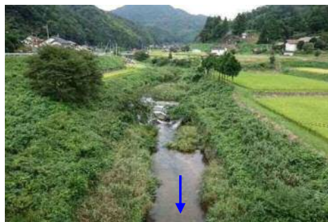
⑨・2 久野川大橋上流 (久野川)
