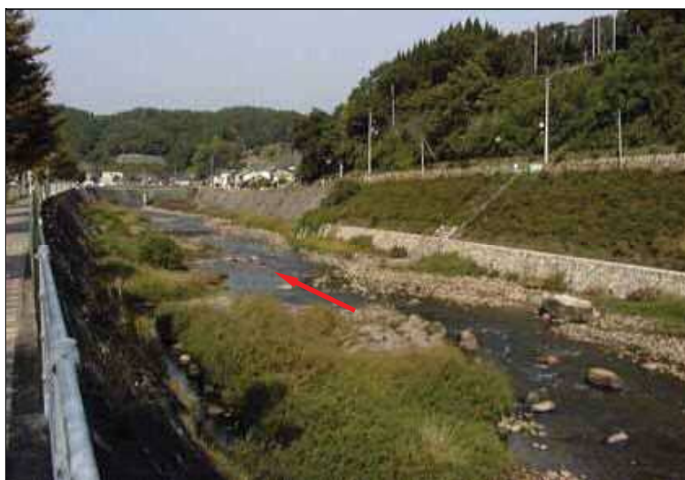
写真9-3 護岸状況（斐伊川：三成）
