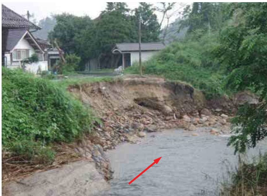
写真7-1 平成18年7月洪水被害状況（斐伊川横田）
