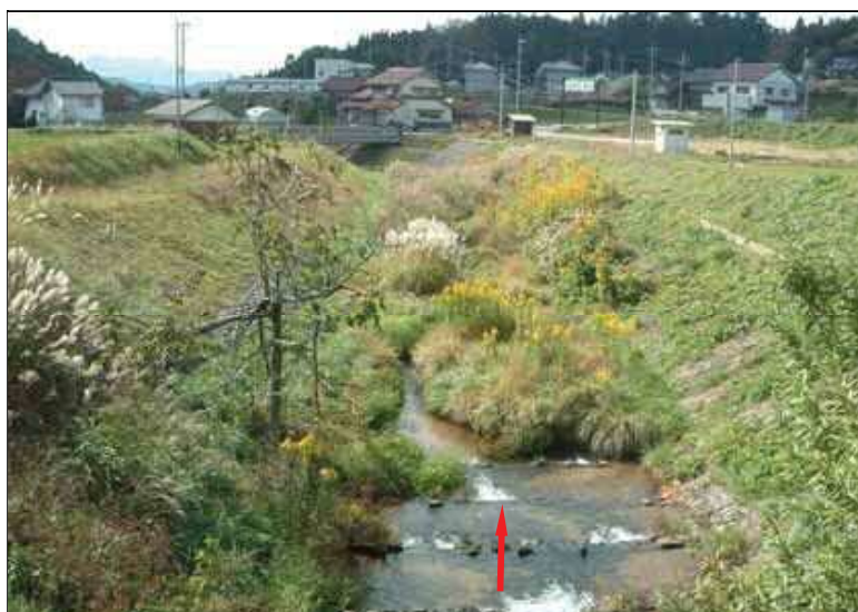
写真9-9 河道状況（亀嵩川）
