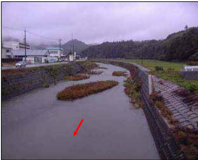
隠岐病院より上流(2k650 付近)
