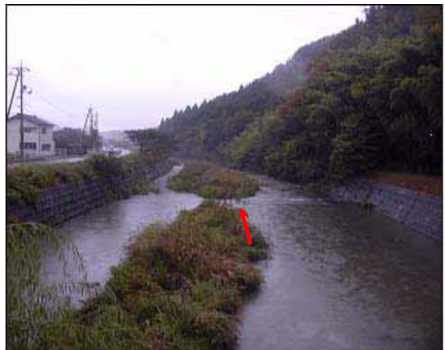
中条橋より下流を望む(5k000 付近)
