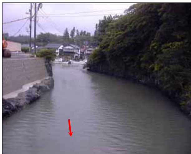
八尾川放水路
